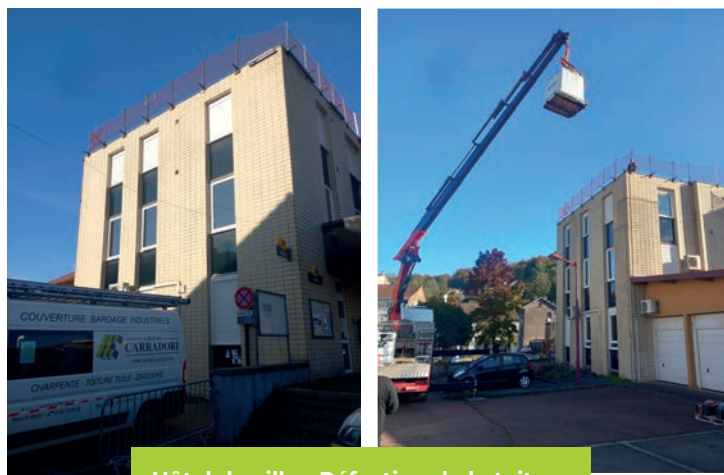
Hôtel de ville - Réfection de la toiture
