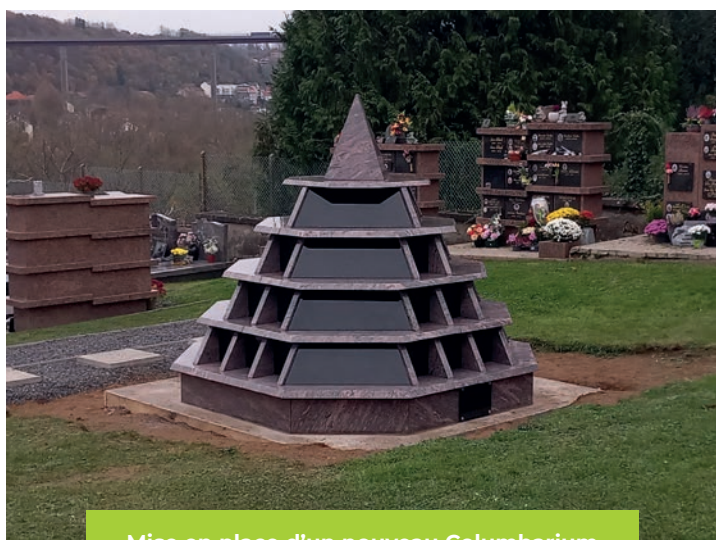
Mise en place d'un nouveau Columbarium
