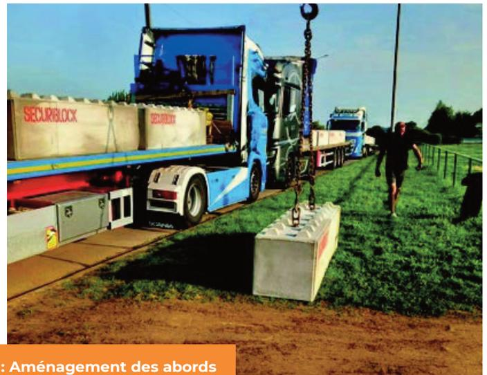
Stade d'entraînement : Aménagement des abords du terrain avec des blocs béton anti-intrusions
